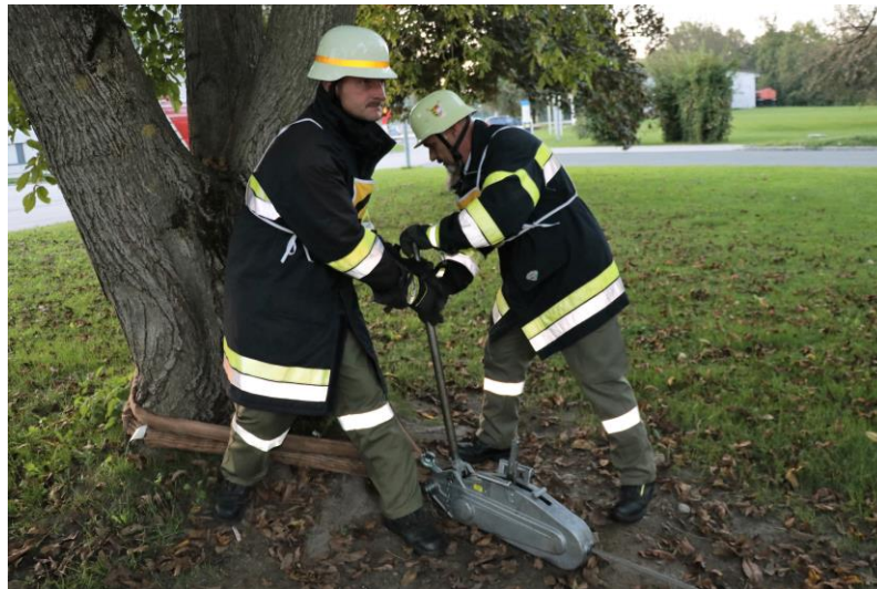
Abb.: Bedienung des Greifzuges
