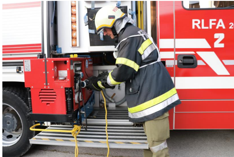
Abb.: Anschließen der Kabeltrommel an das NSA
