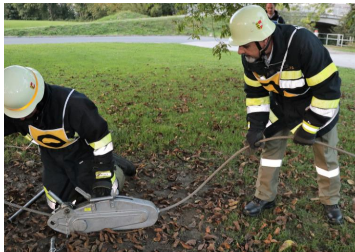
Abb.: Einlegen des Greifzugseiles
